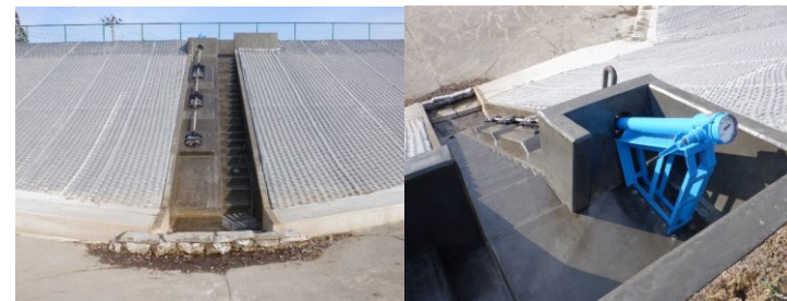
ため池取水設備
