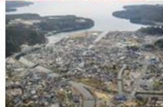
4/3 穴水町 (建物被害多数)
