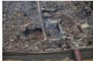
1/2 輪島市河井町 (被災翌日、航空写真)
