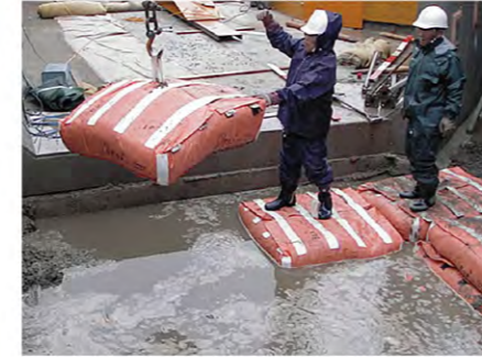
液状化対策+地盤補強(擁壁) (愛知県)
