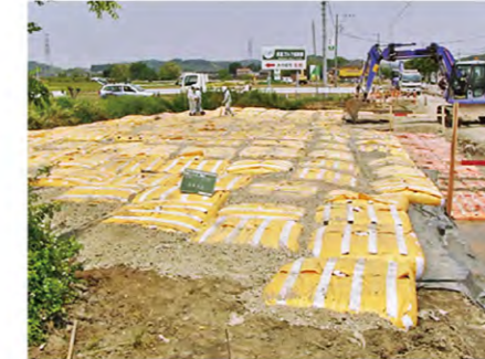
へドロ沼地での地盤補強(駐車場) (埼玉県)
