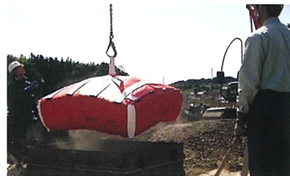
③ 製作後、バックホウで吊り上げD・Boxを専用枠から外す
