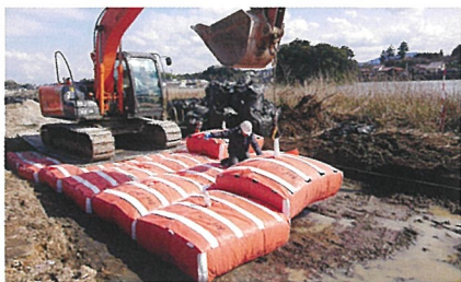
④ 敷設箇所までバックホウで運搬し、設置する
