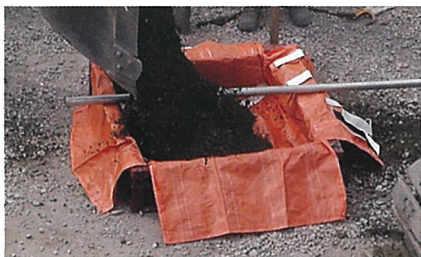
① D・Boxを専用枠にセットし、上部より中詰め材を投入する
