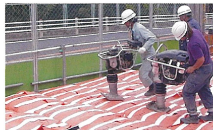
⑥ 敷設が完了したら、ランマーやコンパクターを用いて転圧する
