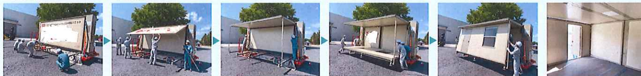
■ 拡幅ハウスコンテナ拡幅作業
