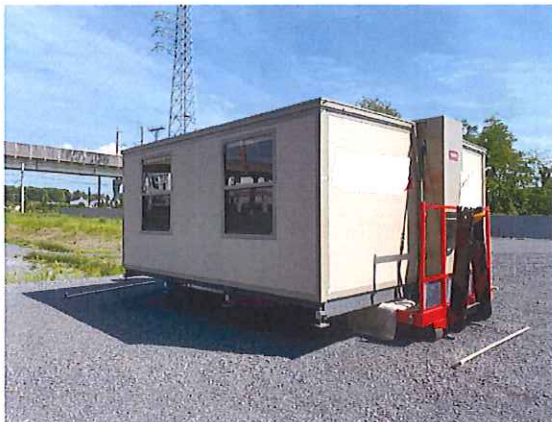
■ 拡幅ハウスコンテナ拡幅作業
